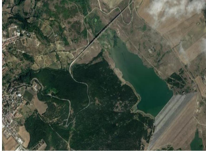
Fig. 2. Diga di Genzano
